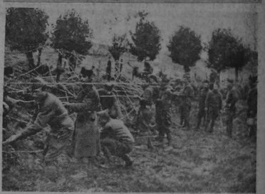
Instalando convenientemente nuevas trincheras, y envolviéndolas inmediatamente con alambradas, en un lugar del frente francés.
